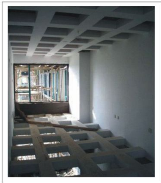
图1 楼板镂空实景图
